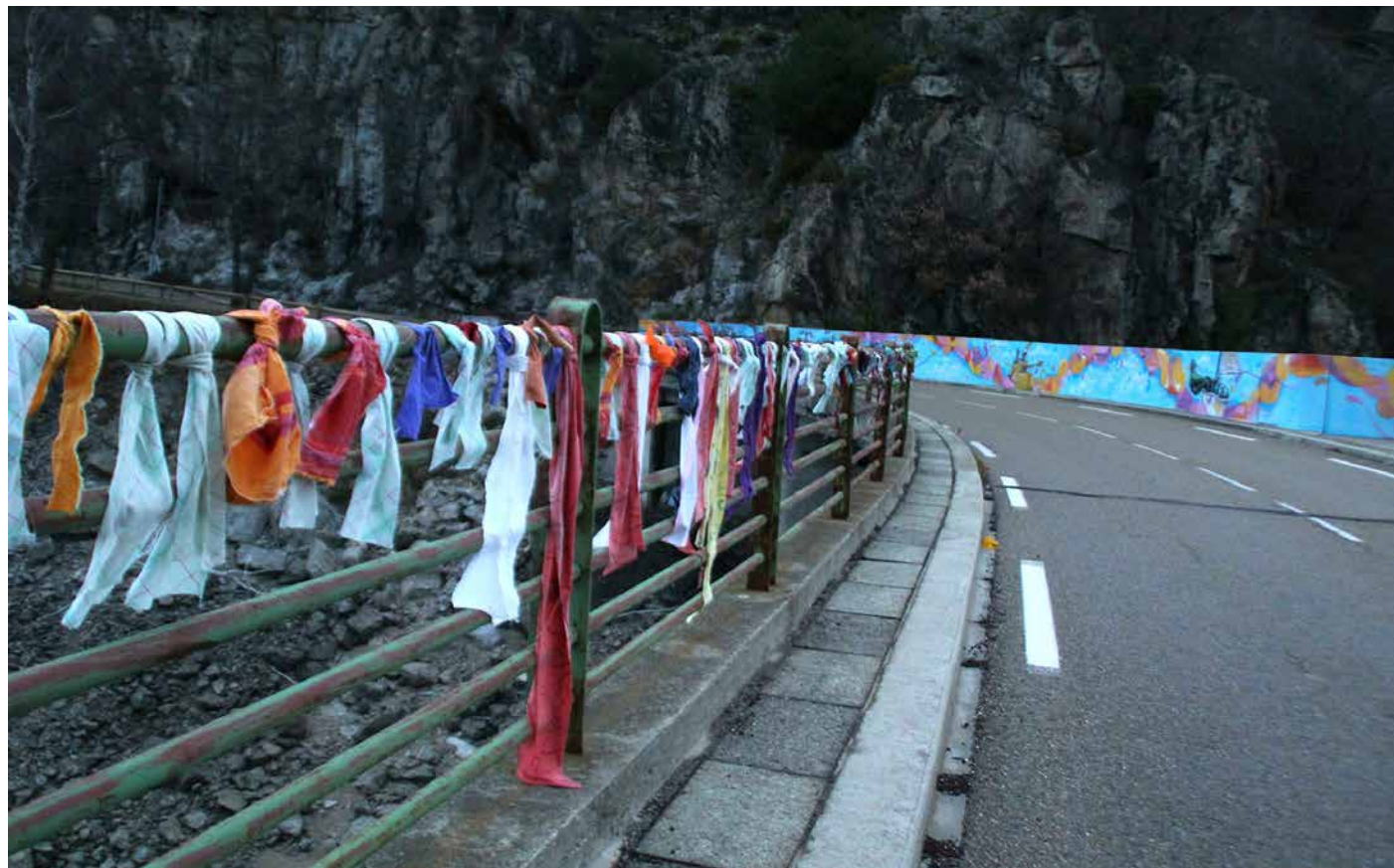
Barrage de Villefort
